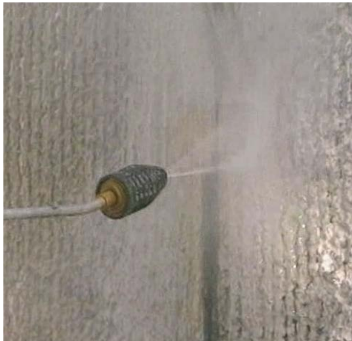
Рисунок 4.3 – Очистка и смачивание трещин, швов водой с помощью гидромонитора
