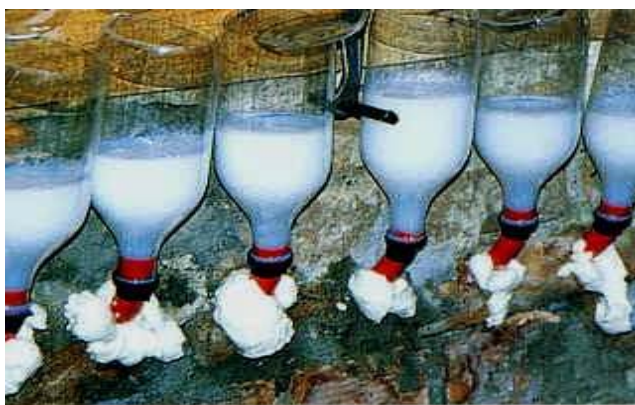
Рисунок 4.7 – Инъекция «ГС Пронитрат Инъекционный» без давления
