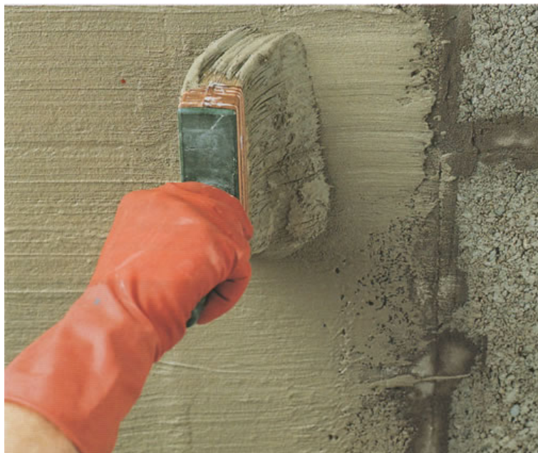
Рисунок 4.4 – Нанесение гидроизоляционного материала «ГС Пронитрат» кистью
