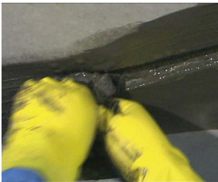
Рисунок 4.5 – Нанесение «ГС Пронитрат Шов» вручную
