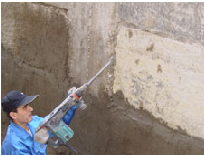
Рисунок 4.1 – Расшивка шва электроперфоратором
